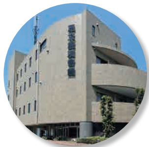
足立鹿浜会館
